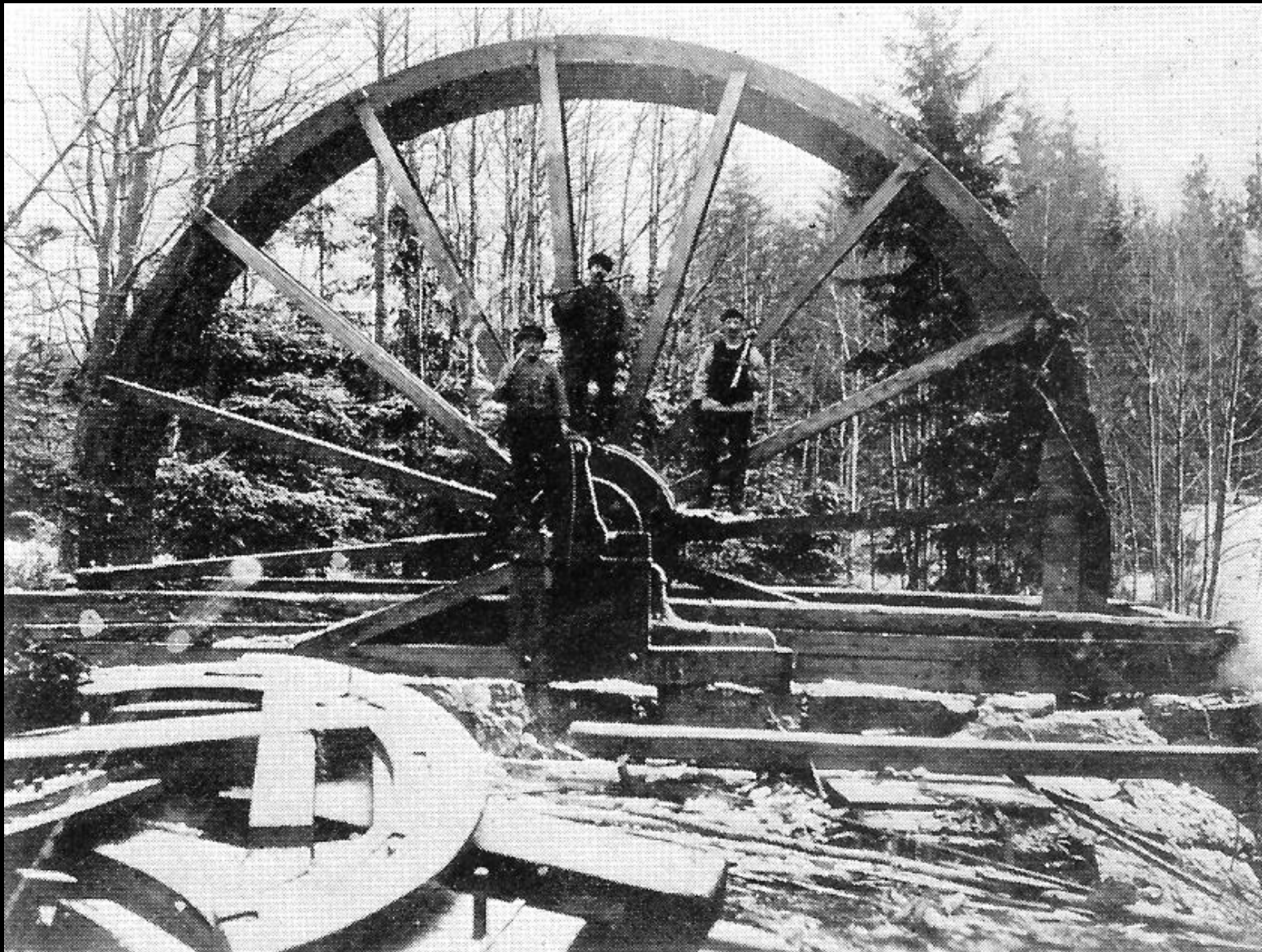
Så kallad "vattenkonst" för att överföra vattenkraft till gruvan
